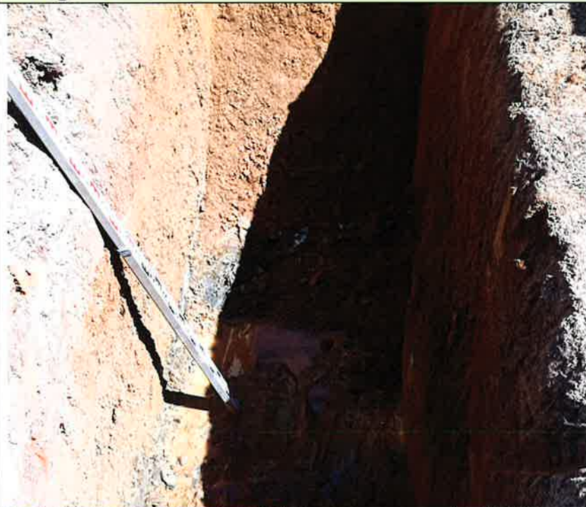
Baggerschurf BS 4 Schurfprofil Aufnahme: 02.06.2021
