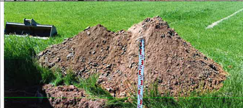
Baggerschurf BS 6 Aushub Aufnahme: 02.06.2021
