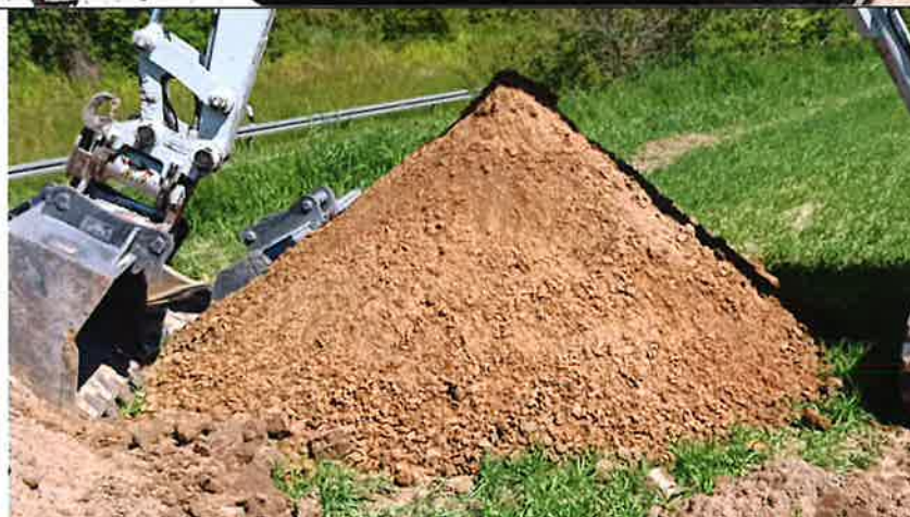
Baggerschurf BS 1 Aushub Aufnahme: 02.06.2021
