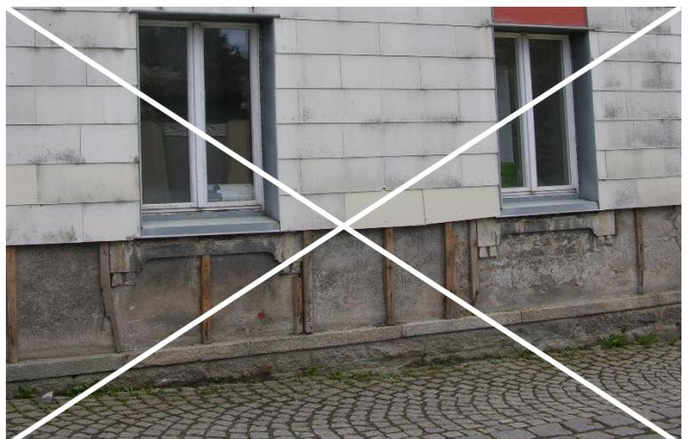
Abb. 5 - Reizvolle Fassadendetails wurden hinter der vorgehängten Fassade versteckt
