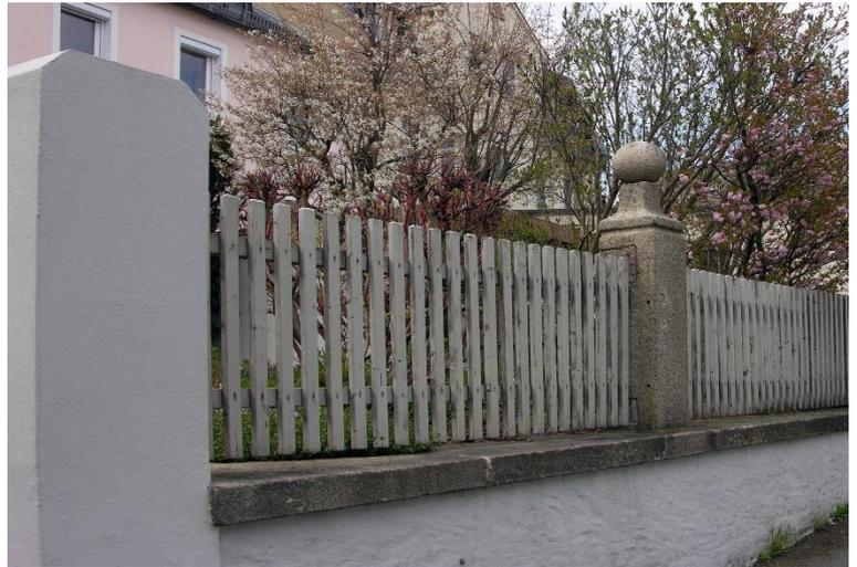
Abb. 118 - Holzlattenzaun mit verputztem Sockel und Eckpfeiler
