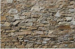
Abb. 41 - Bruchsteinmauerwerk
