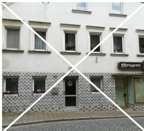
Abb. 35 - Die historische Fassade wurde durch Fliesenverkleidung im Erdgeschoss zerstört
