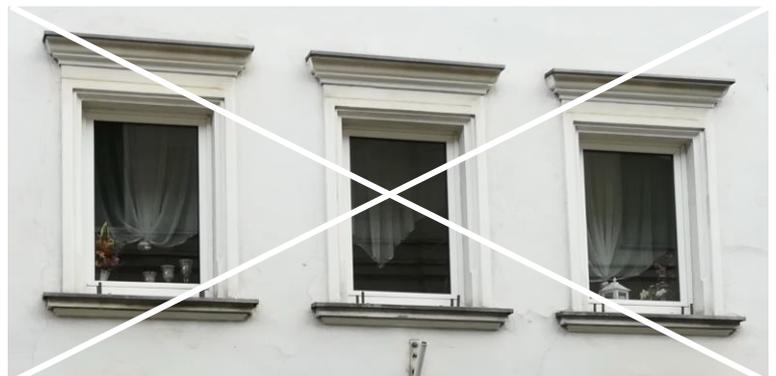
Abb. 62 - Unpassende Einscheibenfenster im Altbau (Gestalt entspricht nicht der Bauzeit)
