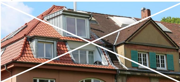
Abb. 85 - Überdimensionierte Gauben, störender Dacheinschnitt
