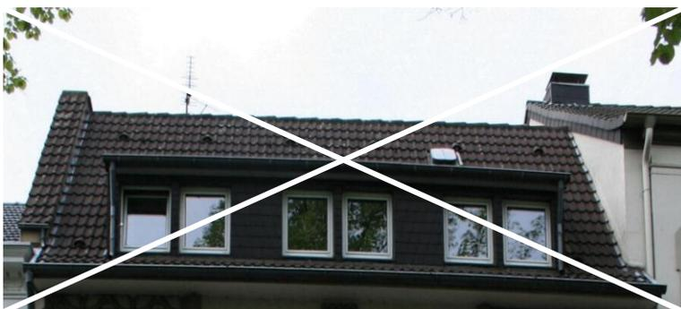
Abb. 87 - Eine Reihung von Schleppgauben soll vermieden werden
