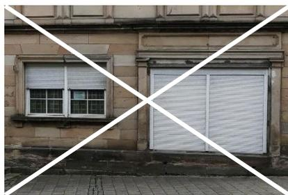
Abb. 67 - Unpassende Fenster und Rollläden im Altbau
