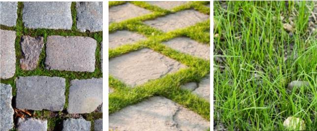
Abb. 113 -115 - Pflaster/Platten mit begrünten Fugen, Schotterrasen
