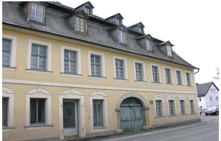
Abb. 61 - Klar strukturierte Fenstereinteilung mit mehrflügeligen Fenstern und glasteilenden Sprossen
