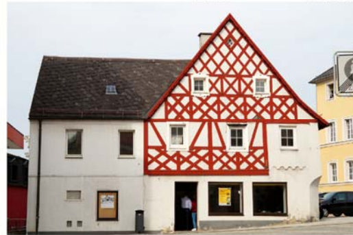
(a) Wohn- und ehem. Geschäftshaus mit jüngerem Anbau von Osten
