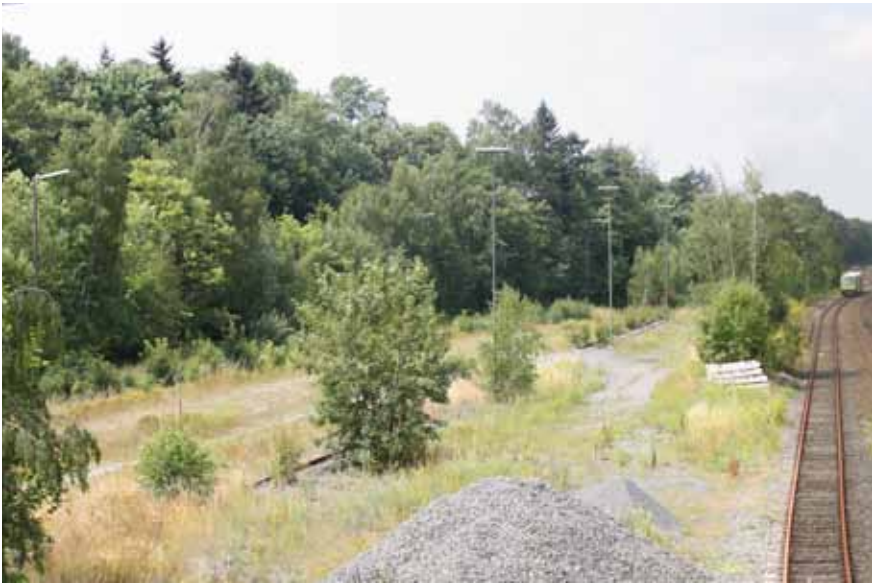
40 Foto Blick vom Luftsteg Richtung Westen, links die Brachfläche Süd
