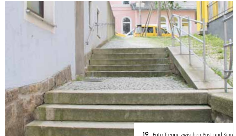
19 Foto Treppe zwischen Post und Kino
