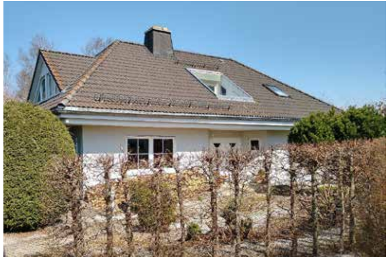
Abb. 4.5.4-1: Beispielhaftes Gebäude aus der Baualtersklasse I. Quelle: EVF 2021 4.5.5
