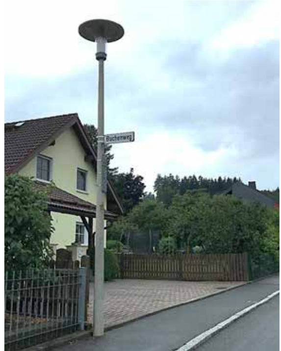
Abb. 4.6.4-1: Umstellung auf LED-Straßenbeleuchtung im Quartier. Quelle: DSK 2021
