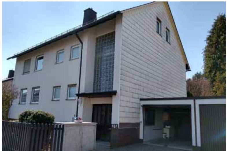
Abb. 4.5.2-1: Beispielhaftes Gebäude aus der Baualtersklasse F und G. Quelle: EVF 2021
