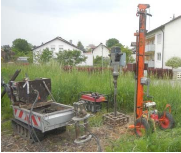
Transporttraupe mit Hydraulikaggregat für hydraulisches Ziehgerät, Stromaggregat, Elektrohammer, Lindenmeyer Rammsondiergerät
