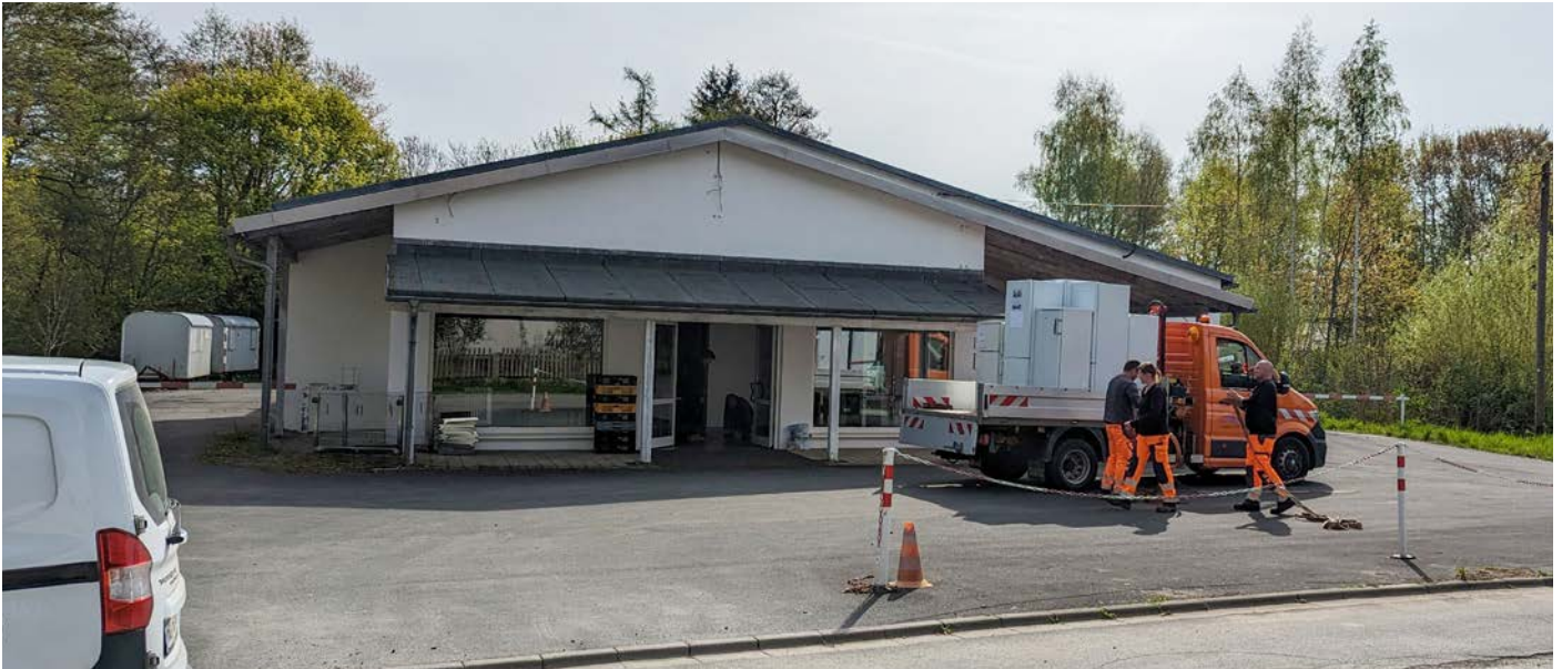
Mit Unterstützung des Bauhofs fand am 8. Mai der Umzug ins renovierte Gebäude statt.
