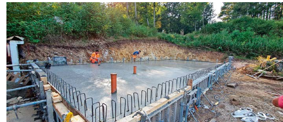
Im September 2020 ging es los: Hier wurde die Bodenplatte gegossen.
