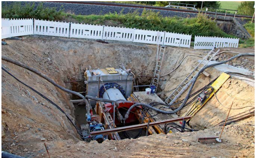
Die Startgrube mit den Hydraulikzylindern.
