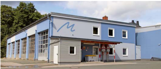
Das Werkstattgebäude am Stadtbauhof erhielt einen neuen Anstrich.
