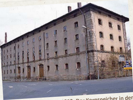
Münchberg im Februar 1992: Der Kornspeicher in der Helmbrechtser Straße kurz vor dem Abriss.
