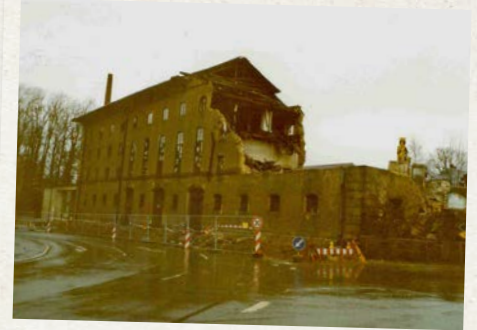
März 1992: Der Abbruch ist in vollem Gange.
