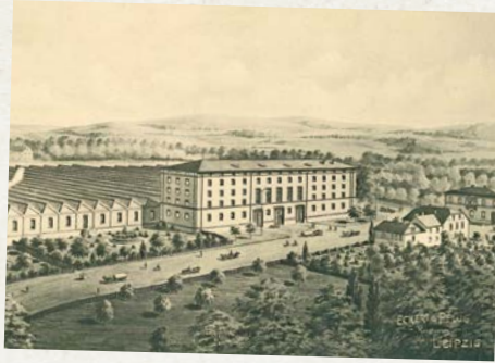
Die Textilfirma Fleißner mit Kornspeicher (zirka 1910).
