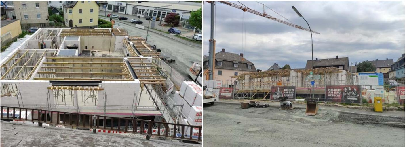
Erfreuliche Nachrichten vermeldet die KWM zum Bau des Mehrfamilienhauses in der Bayreuther Straße: Es geht mit großen Schritten voran. Mittlerweile ist der Keller mit Tiefgarage abgeschlossen. Die Treppe vom Keller ins Erdgeschoss ist eingebaut, das Erdgeschoss hochgemauert. Nun erfolgt die Einschalung und Betonierung der Erdgeschossdecke, bevor die Arbeiten im 1. Obergeschoss weitergehen.
