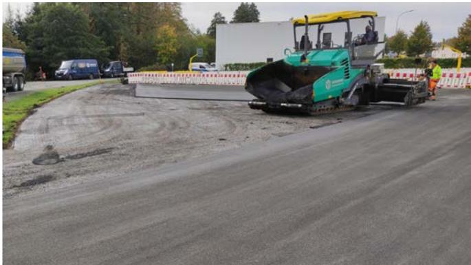
Die Skaterszene darf sich freuen: Die Asphaltdecke am Platz an der Ganghofer Straße wurde im Oktober erneuert. Die Ramps wurden abgebaut und seitlich zwischengelagert. Nachdem die schadhafte Oberfläche abgefräst war, wurde die neue Asphaltdecke aufgetragen, die im Anschluss noch angeschliffen wurde. Nachdem die Geräte wieder aufgebaut sind und unser Bauhof verschiedene Restarbeiten erledigen konnte, steht die Anlage wieder zur Verfügung.
