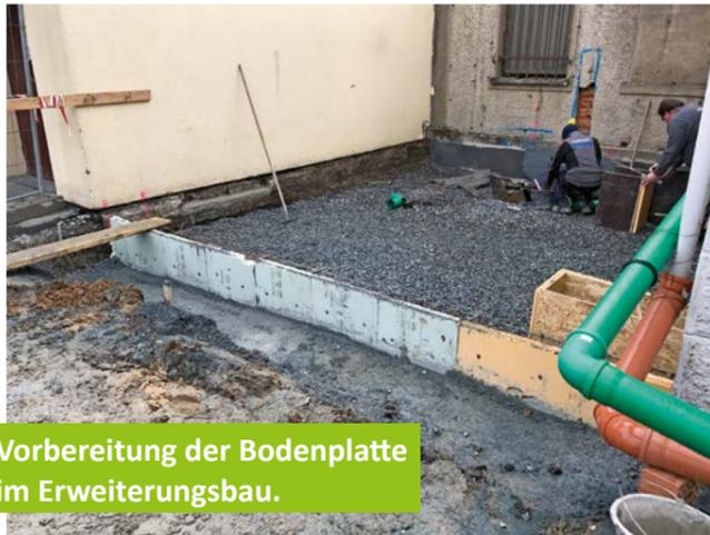
Vorbereitung der Bodenplatte im Erweiterungsbau.
