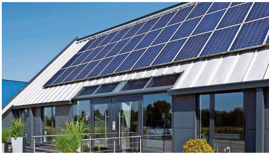
Einen Großteil der benötigten Elektrizität können Unternehmen selbst produzieren das – bedeutet eine deutliche Entlastung auf der Kostenseite. Foto: Foto: djd/Schueco
